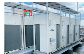
▲更新した冷媒機
